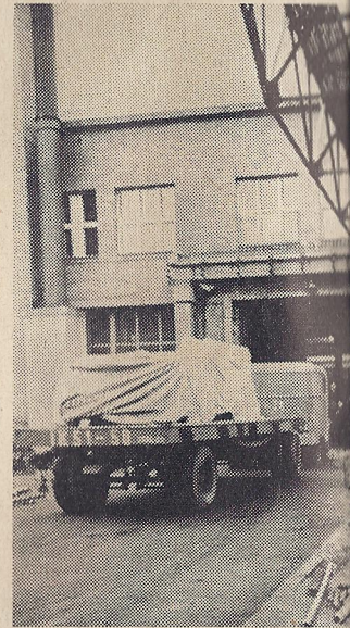
Einfahrt in die neue Halle
