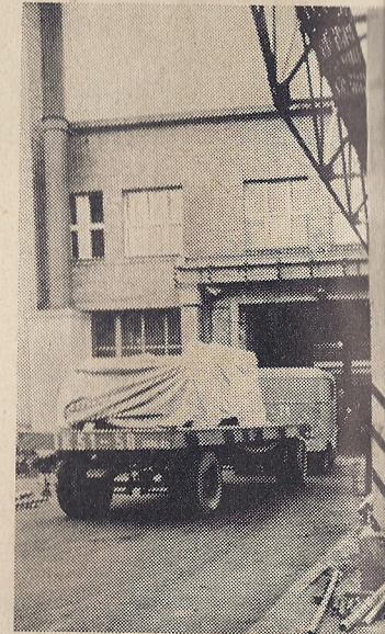
Einfahrt in die neue Halle
